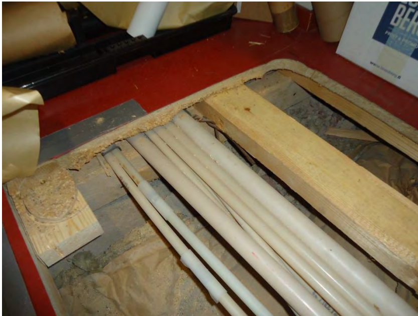
Kuva 9. Varaston 110 lattian rakenneavaus.
