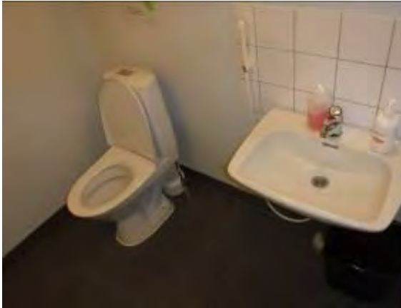
Vesi- ja viemärikalusteet ovat pääosin hyvässä/tydyttävässä kunnossa
