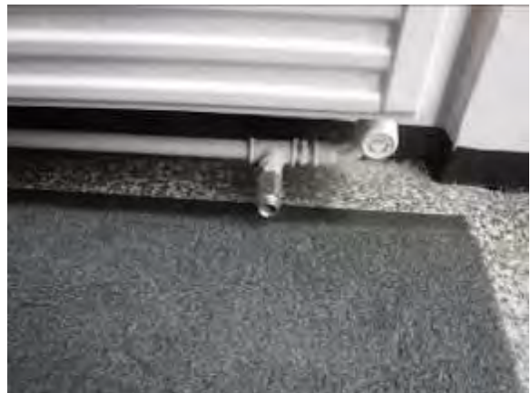
Verkon tyhjennyksen kuulasulkuun olisi hyvä lisätä tulppaus.
