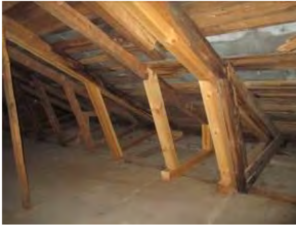
Yläpohjatilat olivat tarkastetuina osin kunnossa, käynti katolle kattolyhdyn kautta.
