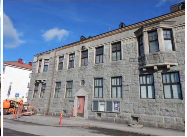
Kuva 3.21 Julkisivu länteen (A-porras, Ristimäen kadulle)
