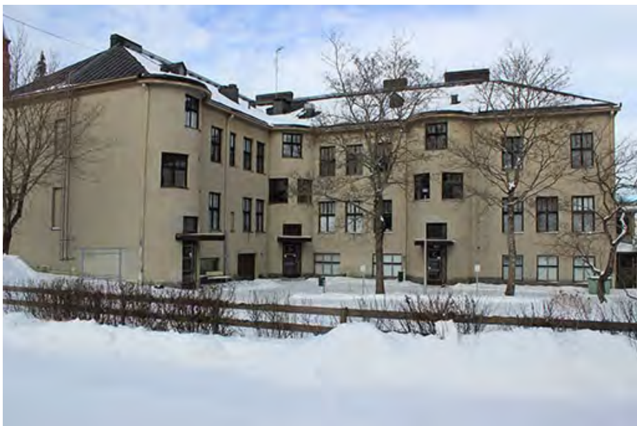
Kuvassa Graniittitalo kuvattuna etelästä vuonna 2017.
