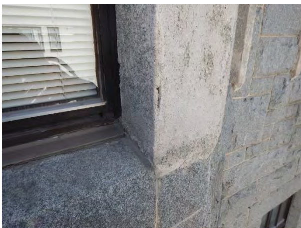
Kuva 3.38 Pohjoissivun erkkerin ikkuna
