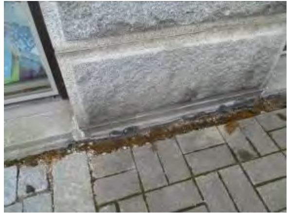
Seinän vierillä on pääosin kiveys tai asfaltti, rakoa on tiivistetty.
