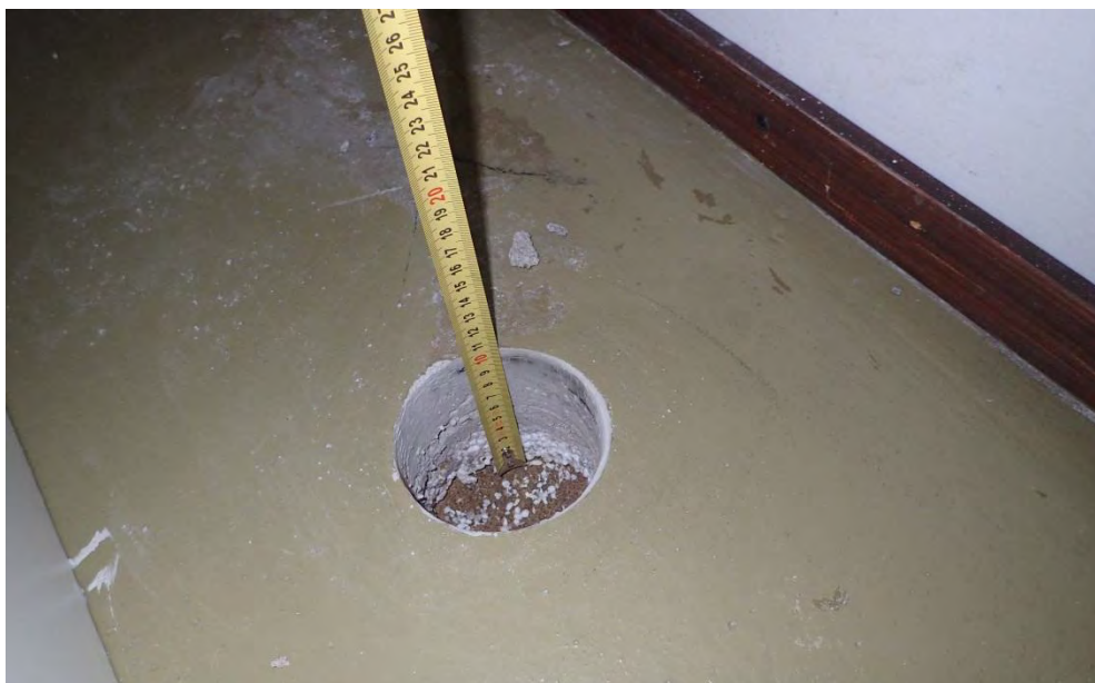
Kuva 2. Tilan 031 alapohjaan tehty rakenneavaus.
