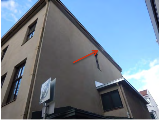
Kuva 3.10 Julkisivun itäpääty (alla roskakatos)
