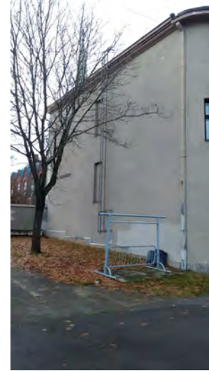
Puretun halkokellarin kohdalla sokkeli betonia ei graniittikivistä.
