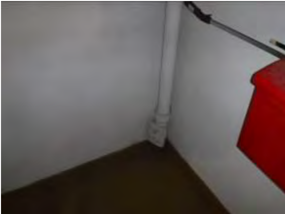
Viemärit ovat valurautaa 70-luvulta.
