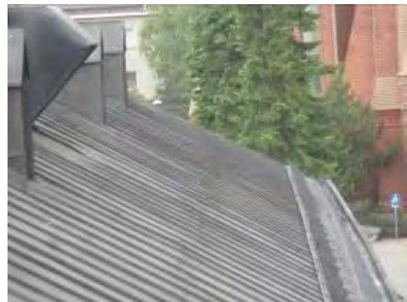
Lumieste ja räystäskouru.
