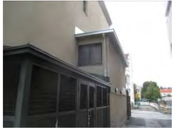
Pääty Carlsonin puolelta, uudet katokset/ katteet.
