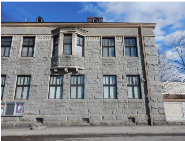
Kuva 3.22 Julkisivu länteen (eteläpääty)
