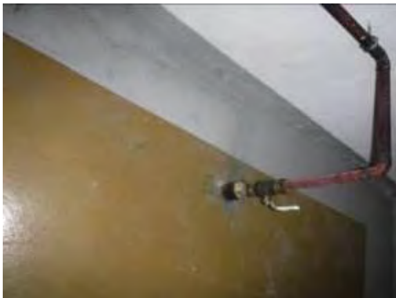
Tonttivesijohto on uusittu
