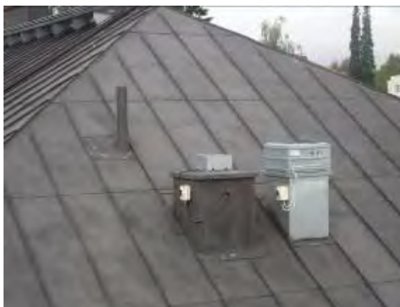
Vesikatolla on kolme huippuimuria vuodelta 1995
