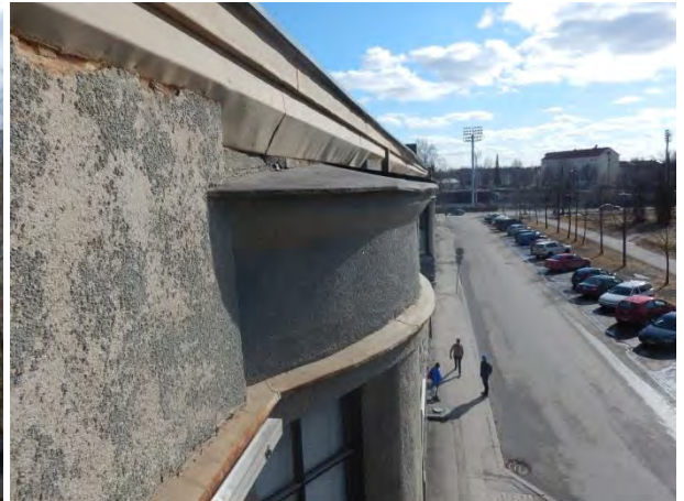
Kuva 3.43 Erkkerin kate, räystään verhouspelti ja vesilippa länsisivulla
