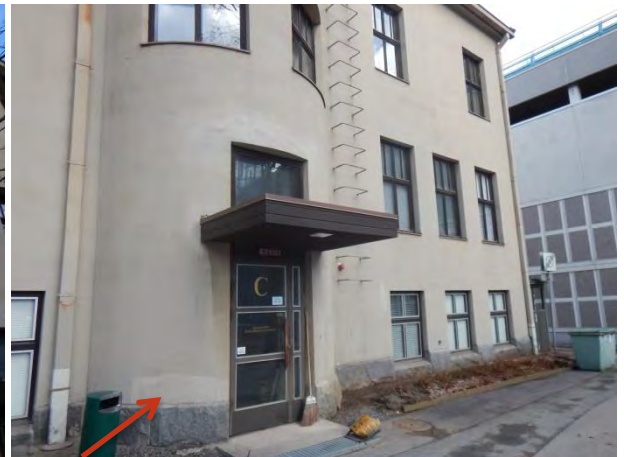
Kuva 3.9 Eteläjulkisivu sisäpihalla (C-porras)
