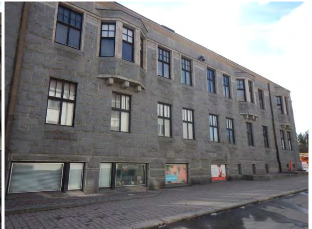
Kuva 3.19 Julkisivu pohjoiseen (Hallituskadulle)
