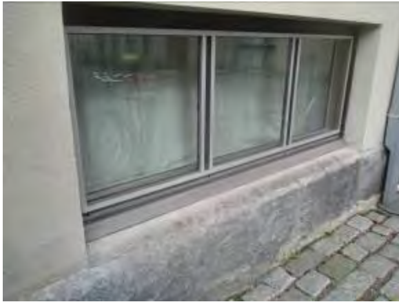
Ulompi puite on nyt osin alumiinia, sisempi puite on puuta.
