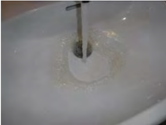
Sinkityistä teräspankista irtoaa ruostetta, joka värjää kylmää vettä ruskeaksi.
