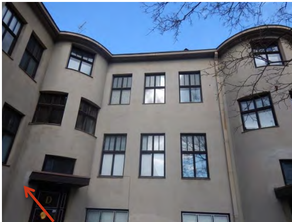
Kuva 3.8 Eteläjulkisivu sisäpihalla (D-porras)
