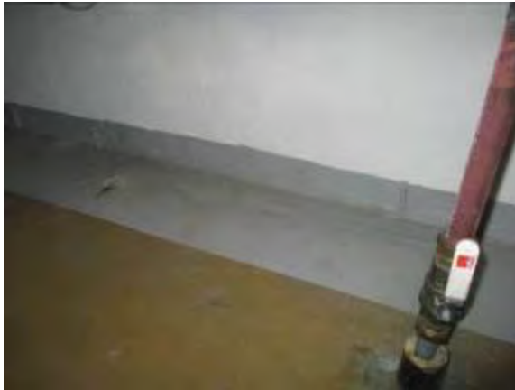
Kellarin lattioissa on osin maalipintaa ja seinärajoja on jo tiivistetty, nyt ei havaittu kosteutta.
