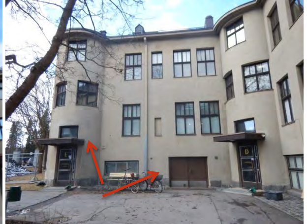
Kuva 3.7 Itäjulkisivun sisäpihalla (E- ja D-porras)
