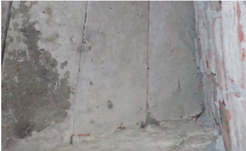
Kuva 16. C-portaan alustatilan kattoa.
