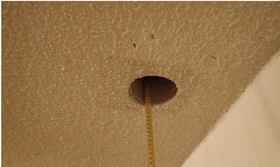
Kuva 6. Rakenneavaus tilan 031 kattoon (välipohjaan).
