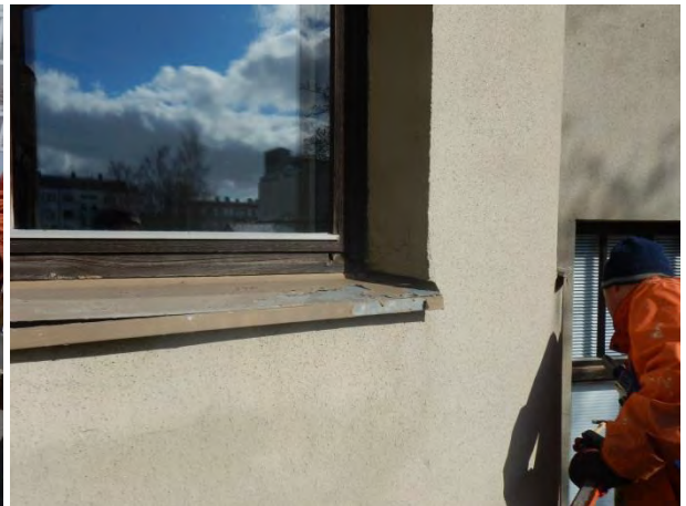
Kuva 3.37 Vesipelti repeytynyt
