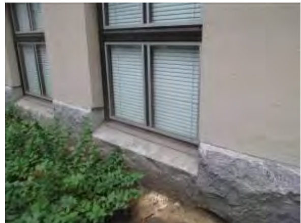
Ikkunarakenteet ovat pääosin 2- puitteisia puu/alumiini- ikkunoita.
