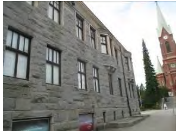
Yleiskuvaa julkisivusta ja ikkunoista kävelykadulta.
