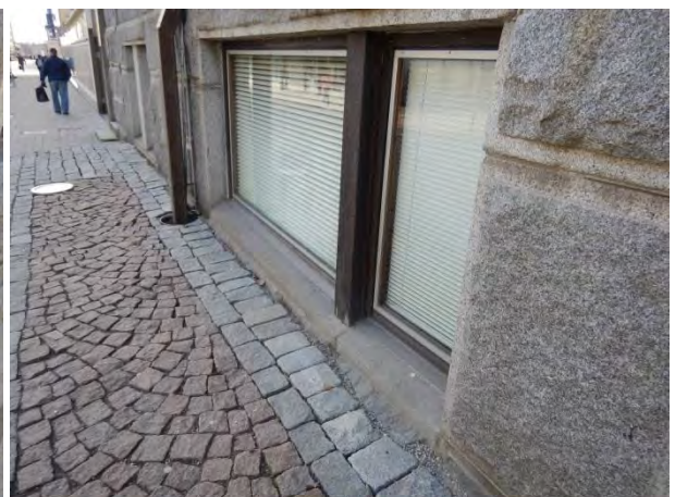
Kuva 3.39 Kellarin ikkuna pohjoispuolella
