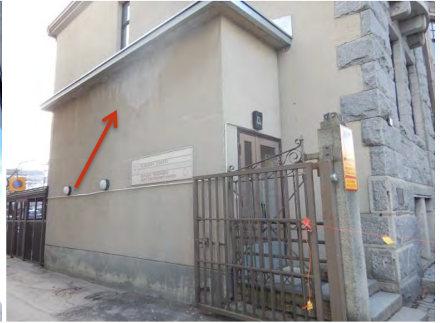
Kuva 3.11 Julkisivun itäpääty (B-porras)
