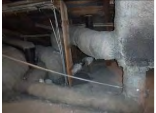
Kanavisto on eristetty ullakolla
